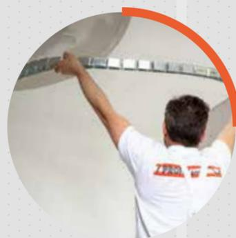
Si possono **piegare facilmente** a mano in tutte le direzioni. **Mantengono la curvatura** desiderata una volta piegati, e non hanno bisogno di strumenti di fissaggio supplementari.
