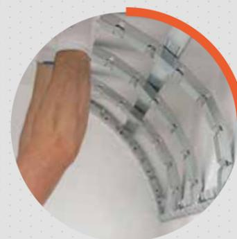
Possono essere facilmente piegati a mano e fissati alla parete da **una sola persona**, riducendo il tempo di costruzione di tutte le strutture curve, con un notevole risparmio di costi di manodopera.
