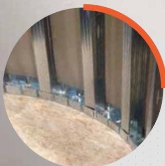
I montanti standard verticali scivolano facilmente all'interno della Guida Flessibile COBRA nella creazione di una parete curva e una volta nella posizione desiderata, **si bloccano automaticamente** e restano perfettamente perpendicolari.
